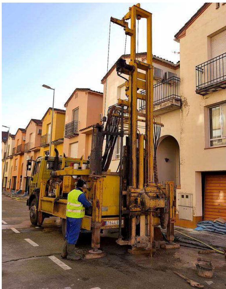
La máquina realizaba perforaciones para conocer más sobre el subsuelo en esta zona de Talavera. / L.G.C.
