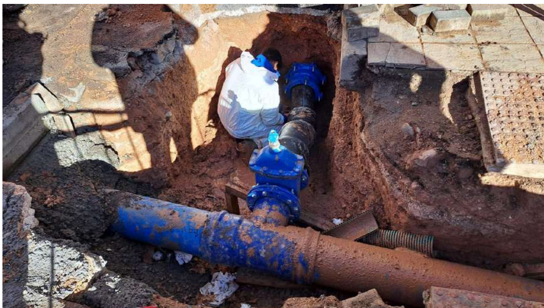
Plan de Obras en Infraestructuras Hidráulicas en Bolaños de Calatrava / Lanza
