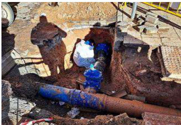
Trabajos realizados en una de las calles. / LT
